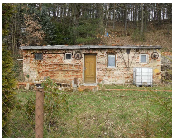
Zděná stavba č.e. 58 na parc. č. 893 - nyní jako zděná kolna
